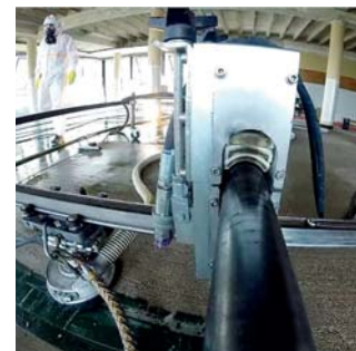
Robot AS PROTEK® procédant au désamiantage de dalle vinyl-amiante au sol. www.asprotek.fr
