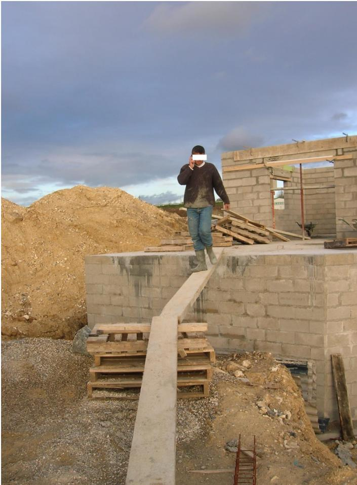
Des accès sûrs et en nombre suffisants doivent être installés. Le remblaiement le plus tôt possible est préconisé notamment pour mise en place d'un échafaudage de pied
